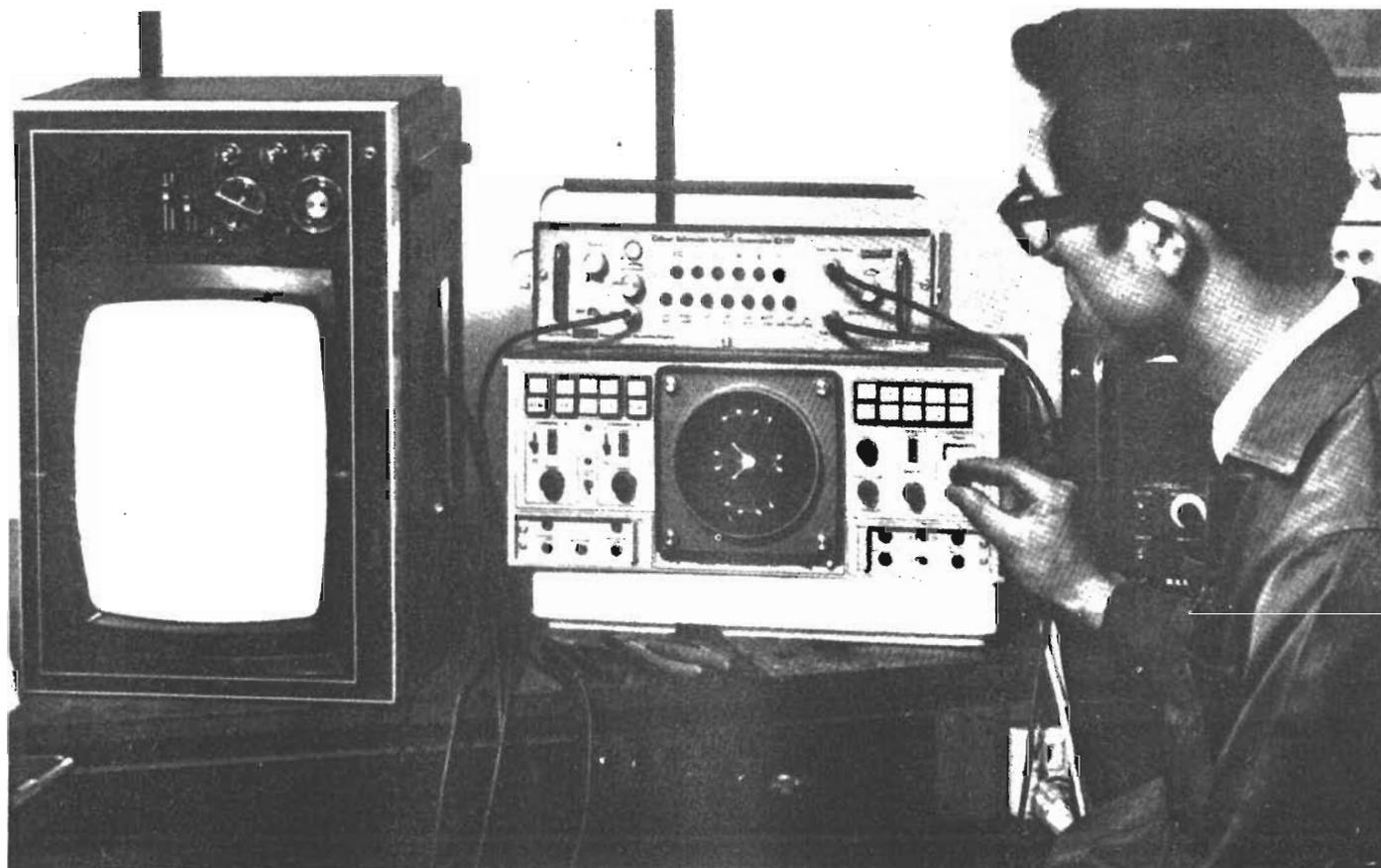
Uso del generatore di frequenza per la taratura degli apparecchi televisivi. Sotto, il recorder con il diagramma delle oscillazioni.
